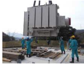
③変圧器据付
