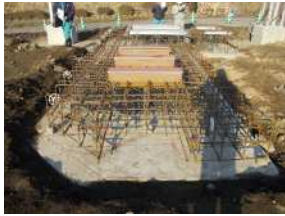
①基礎配筋
