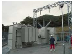
⑧工事完了
