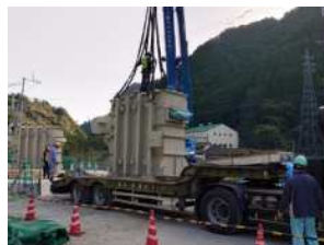
機器取り卸し
