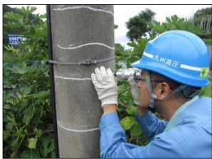
ひび割れ調査 (測微鏡)
