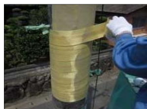
繊維シート補修工法
