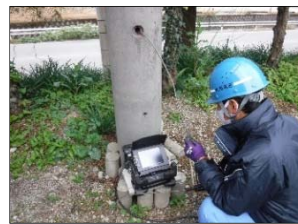
内部状況調査 (ファイバースコープ)
