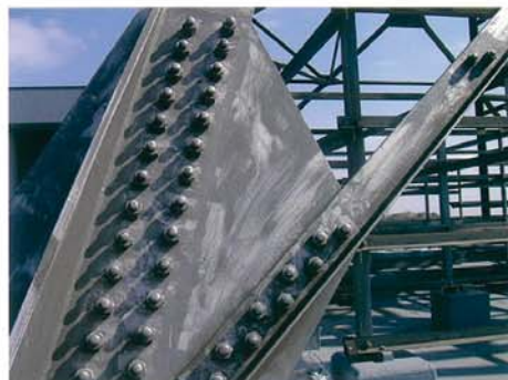
筑紫大谷局鉄塔 (塗装後 9 年経過) 二液性:エポキシ樹脂塗料を使用したもの。
