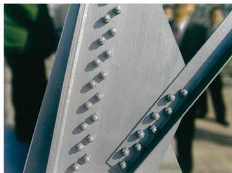
唐津局鉄塔 (塗装後 9 年経過) 一液性:ケミカルバック MPT-NT を使用したのもの。
